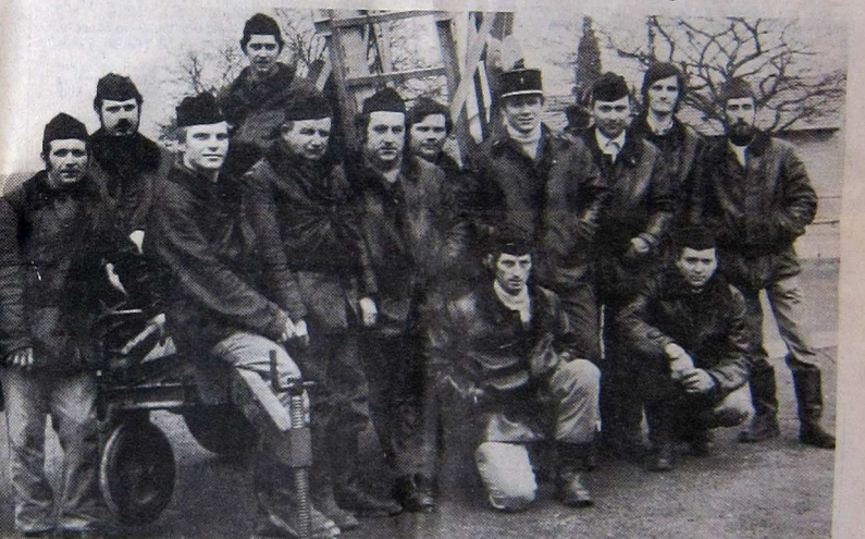
Au pied de la grande échelle, au cours d'une des manoeuvres du premier dimanche de chaque mois.
